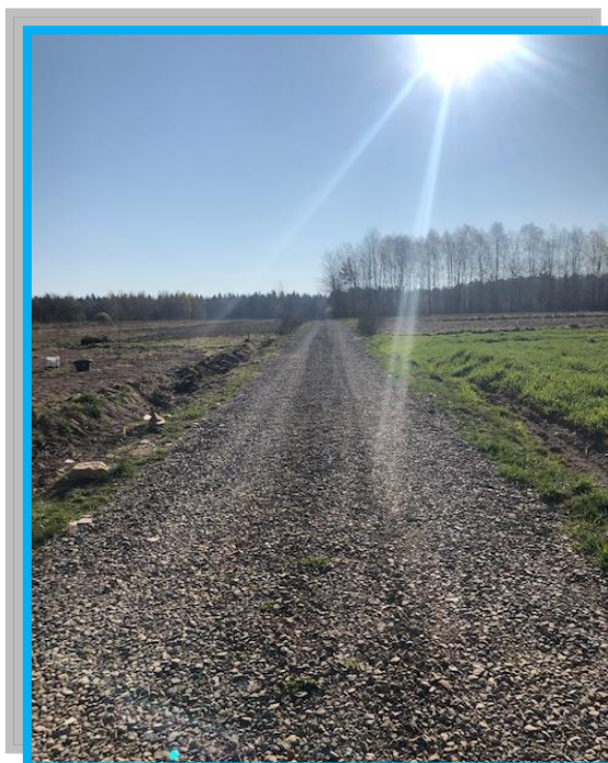
Droga wewnętrzna w miejscowości Bartoszowiny – po modernizacji
